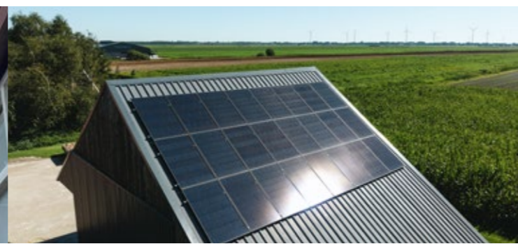
Drouwenermond o 24 monokristallijne zonnepanelen van REC o Omvormer SMA STP10.0
