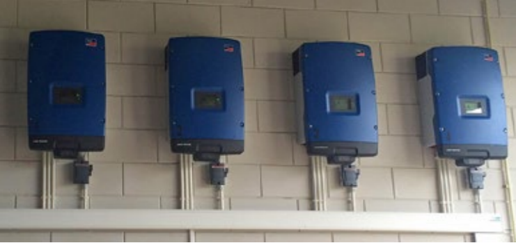
Stadskanaal, bedrijfspand o 150 polykristallijne zonnepanelen. o 4 krachtige SMA omvormers
