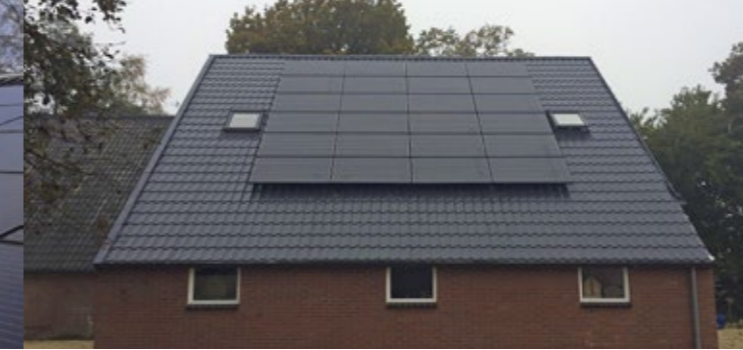
Tynaarlo, zonnepanelen op dakpanplaten o 24 monokristallijne zonnepanelen van Bauer o Omvormer SMA
