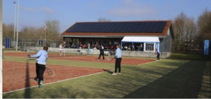
Nieuw-Buinen, tennisbaan zelfvoorzienend o 60 monokristallijne zonnepanelen van Bauer o Omvormer SMA
