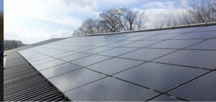
Nieuw-Buinen, boerderij o 90 monokristallijne zonnepanelen van Bauer o Omvormer 2x SMA
