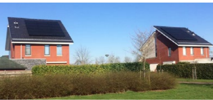
Smilde, twee identieke zonnestroominstallaties o Per installatie 20 LG zonnepanelen o Omvormer en optimizers van SolarEdge
