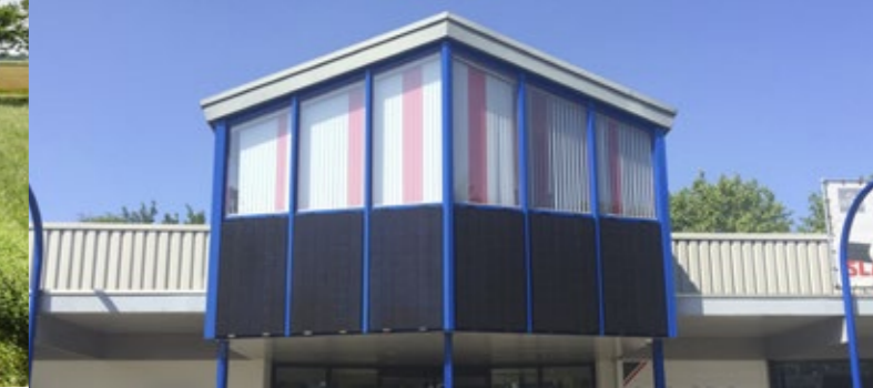
Borger o 6 Zonnepanelen van LG 'Neon 2 black' aan de gevel geplaatst. o Omvormer en optimizers van SolarEdge
