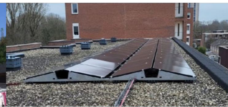
Groningen, VVE o 72 zonnepanelen van Jinko o Omvormer Goodwe
