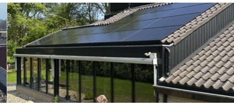
Stadskanaal, indaksysteem o 36 zonnepanelen van Jinko in oost-west opstelling o Omvormer Goodwe
